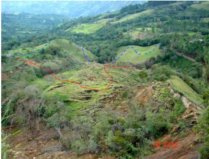
Sector del centro del deslizamiento, con el volcamiento de un gran bloque de la masa de suelo parte del flanco derecho. La línea roja punteada corresponde a la posición aproximada de la carretera original, y con la línea azul se indica el trazado preliminar de una variante.
