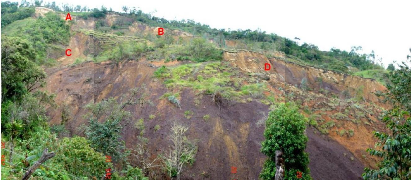
1-Vista general del deslizamiento tomada desde la carretera a Belén, adelante del mismo. El movimiento de esta gran masa de suelo destruyó casi 300 m de la carretera La Unión – Belén. En **A** se localiza el escarpe principal del deslizamiento, en **B** el flanco izquierdo y en **C** el flanco derecho, con un flujo de tierras en su vecindad.
