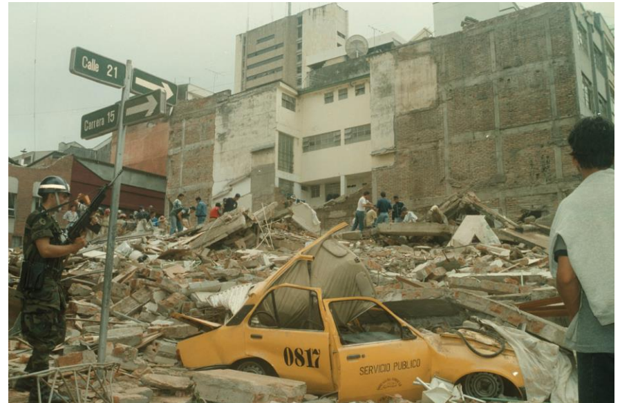
Edificio de la carrera 15 en Armenia después del terremoto de 1999.
