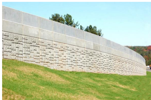
Paneles de concreto
