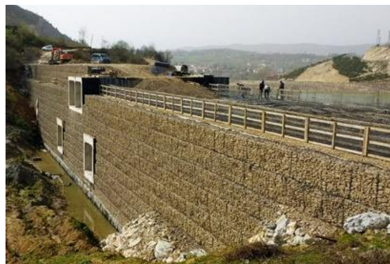
Fachadas de gavión
