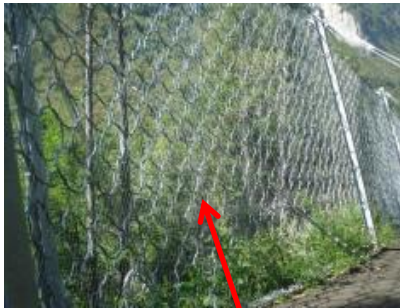
Estructura de interceptación (módulo funcional)
