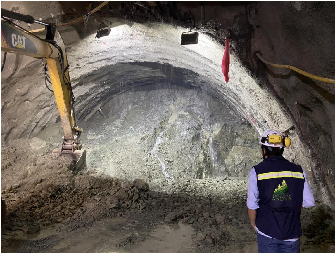
Figura 9. Tratamiento en zona de Falla Patía.
