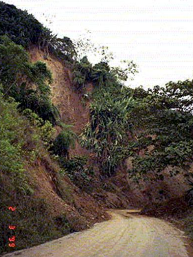
Deslizamiento Vía Pereira-Armenia y Armenia-Pijao Sismo Quindío 25-ene-1999.
