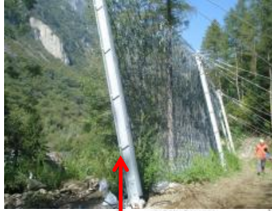
Estructura de Soporte (postes)
