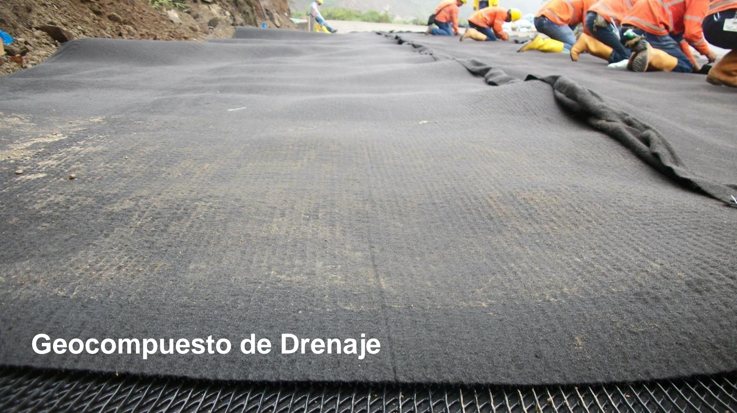
**Geocompuesto de Drenaje**
